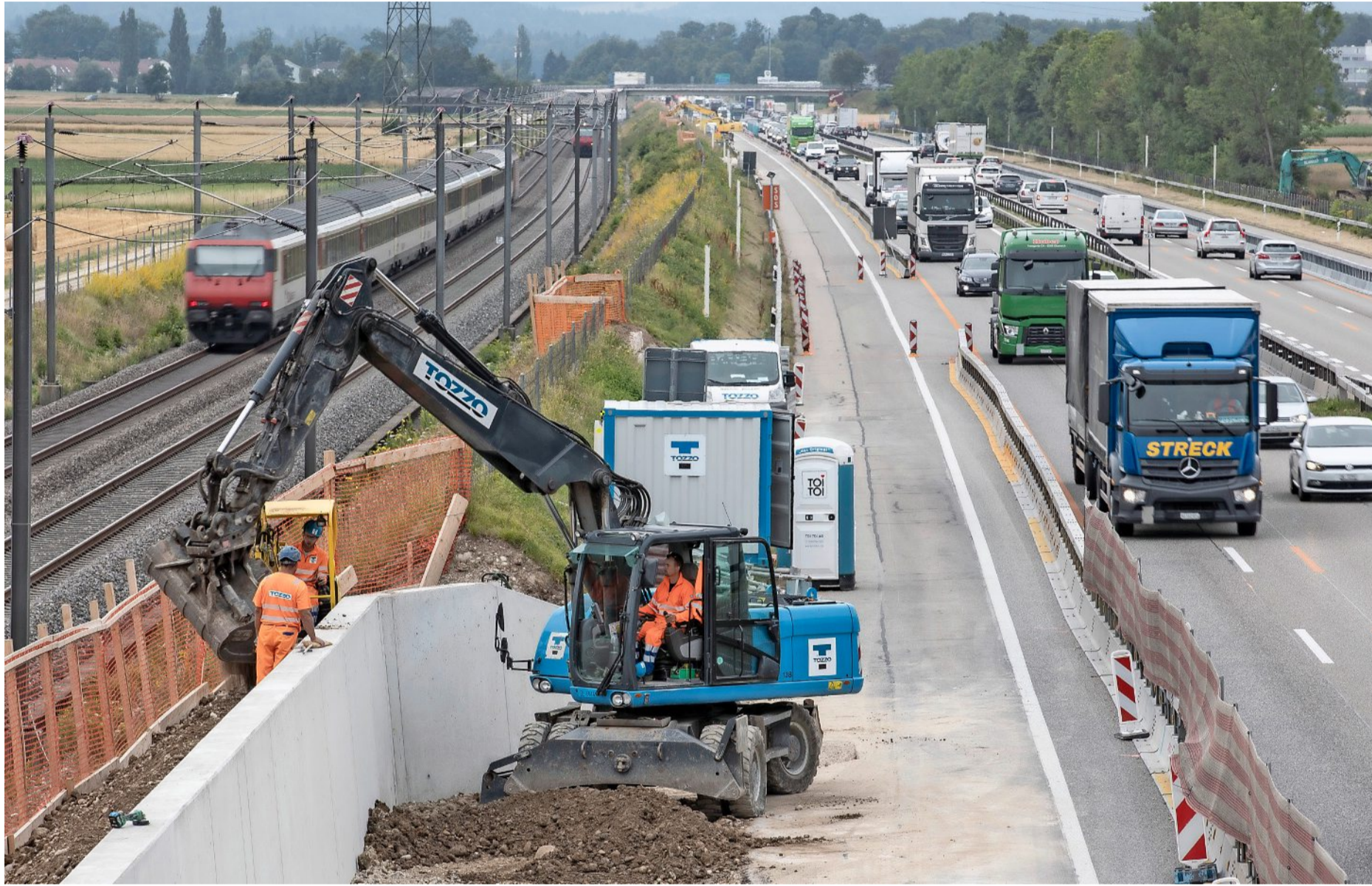
Gebaut wird tagsüber. Mobile Leitplanken und orange Markierungen führen den Verkehr. Foto: Beat Mathys
